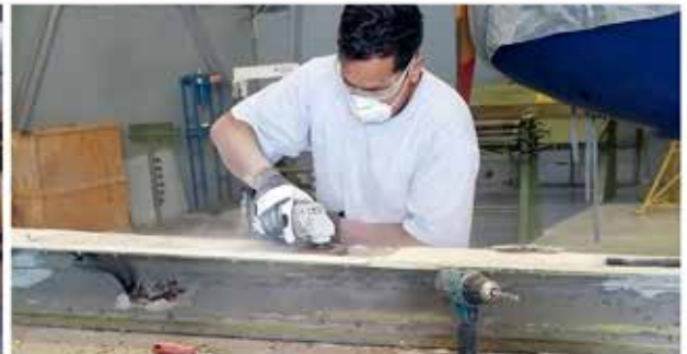
Reparación borde de ataque.
