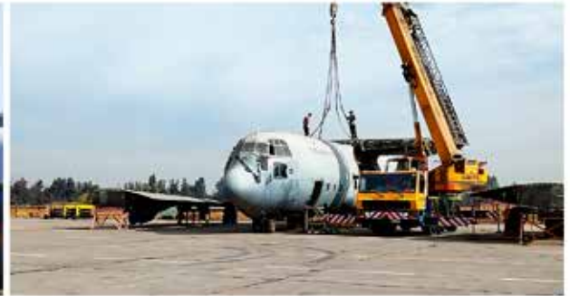
Desmontaje del Centro plano en avión C-130.
